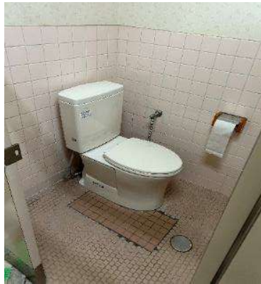
▲改修完成写真(和式から洋式へ)
